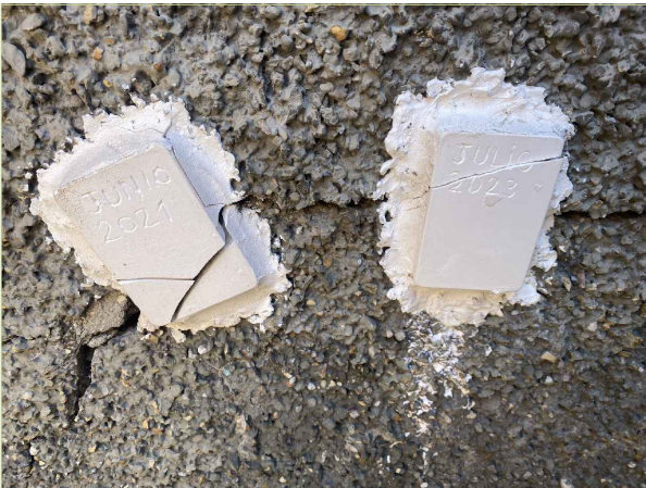
Testigos colocados a lo largo de todo el edificio en aquellas zonas más afectadas.
