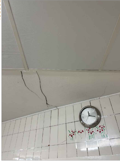
Grietas en faja de escayola en falso techo
