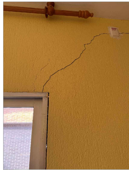
Grietas en paramentos de fábrica
