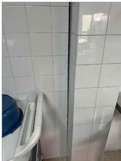
Grieta entre paramento vertical y elemento estructural en almacenes.
