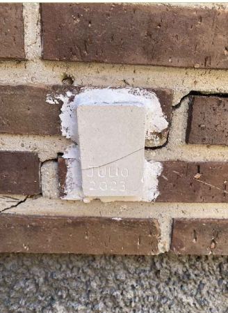
Testigos colocados a lo largo de todo el edificio en aquellas zonas más afectadas.
