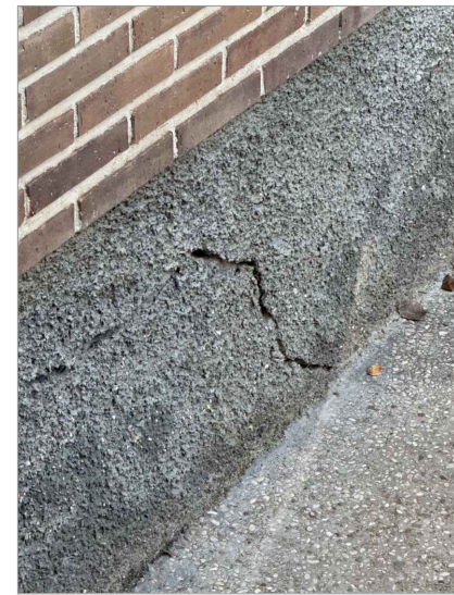
Grietas enfoscado de cámara sanitaria
