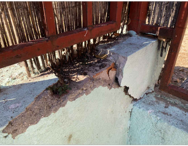
Grieta transversal en el enfoscado y desprendimiento del mismo.
