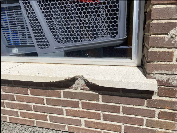
Vierteaguas de piedra artificial rotos
