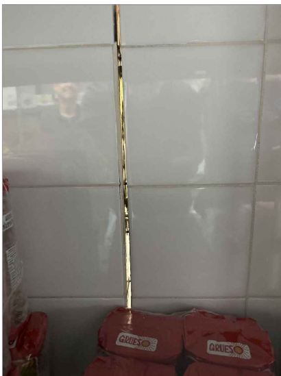
Grieta entre paramento vertical y elemento estructural en almacenes.
